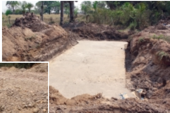
Construção de bueiros nas estradas do Assentamento Barreirão
