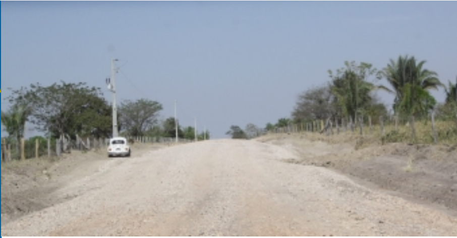
Construção e melhoramento das estradas do Assentamento Barreirão.
