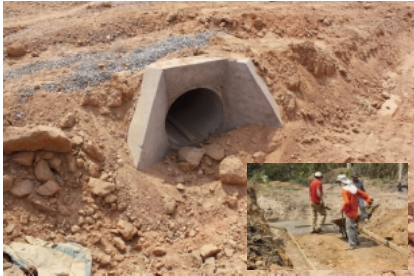
Construção de bueiros nas estradas do Assentamento Barreirão
